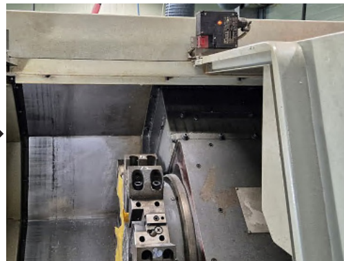
기존설비 안전장치(인터락) 보수
