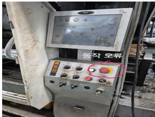
안전문 센서 및 비상스위치 미작동
